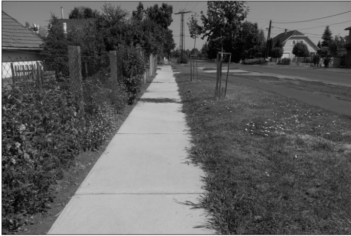
Az Arany János utcai járda felújított szakasza
