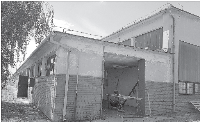
Újabb munkahelyek létrehozását is célul tűzték ki a felújított József-major bérbeadásával
