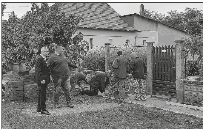
Belügyminisztériumi pályázat támogatásával megkezdték a járdák építését
